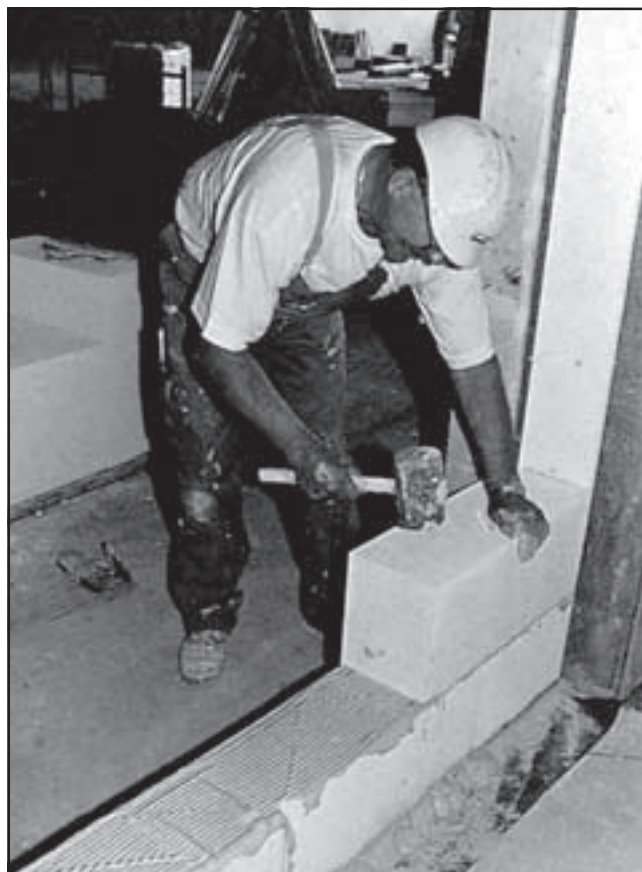
4. Colocar la siguiente hilada de bloques.
